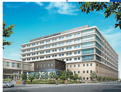
●現在建て替え工事が進む高槻病院新棟（地上9階）
