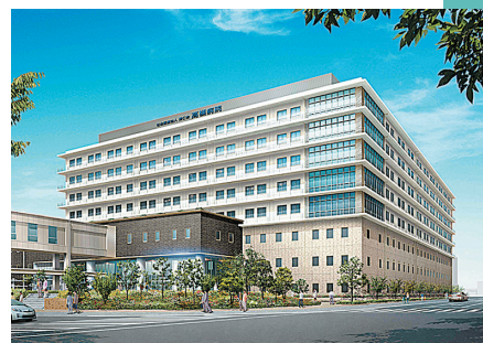
▲現在建て替え工事が進む高槻病院新棟（地上9階）
